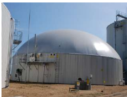
Zbiornik 2-membranowy dach 2200 m 3 Biogazownia Szepietowo
